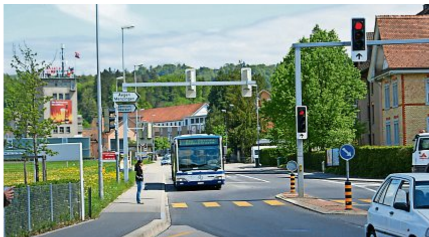
Die Baudirektion des Kantons Zug führt am Knoten Langgasse/Ägerstrasse in Baar Belagsreparaturen durch. ZW-Archiv/DK
